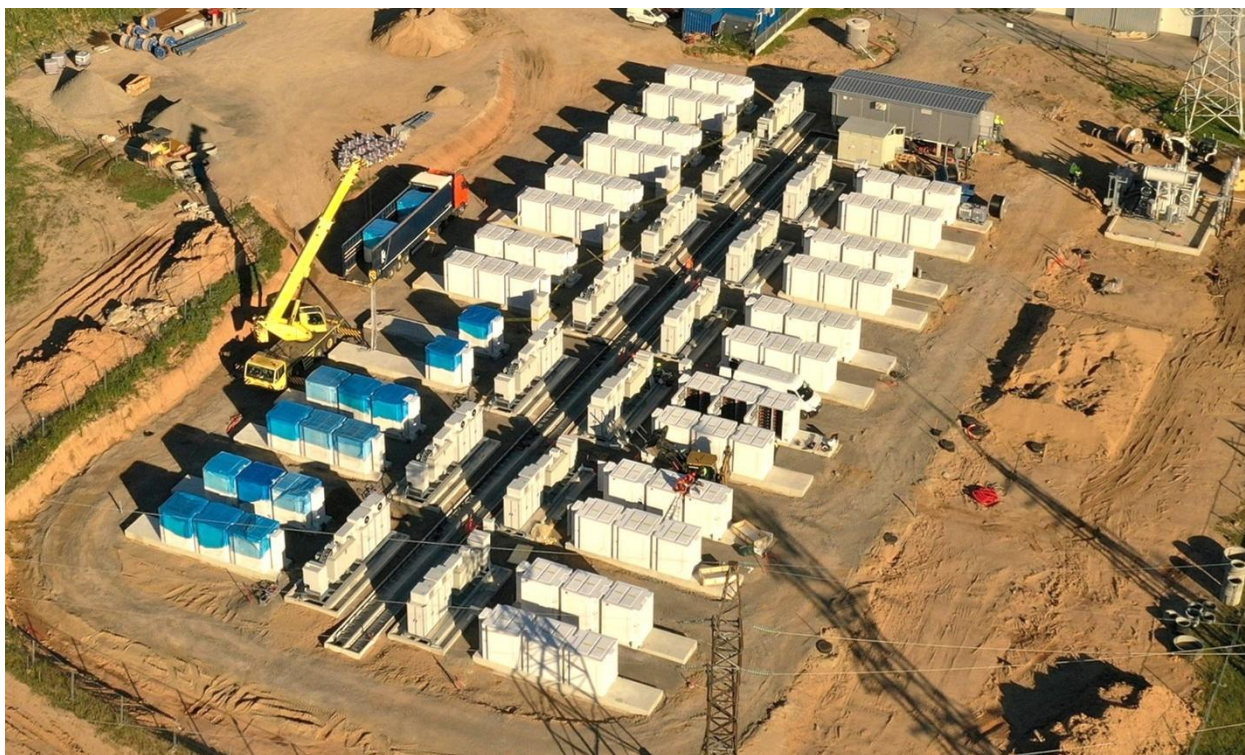
2.3.3 pav. EEKS statybų aikštelės ir įrenginių iškrovimo organizavimo pavyzdys (nuotraukos šaltinis: https://enmin.lrv.lt/lt/naujienos/energy-cells/ ).
