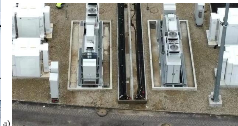
2.8.1 pav. PCS transformatoriaus įrengimo atsižvelgiant į aplinkosauginius reikalavimus pavyzdžiai.
